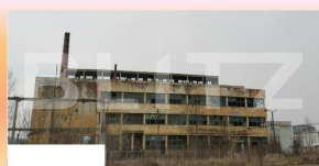
Exterior cladire P+2E C2
