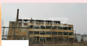
Exterior cladire P+2E C2
